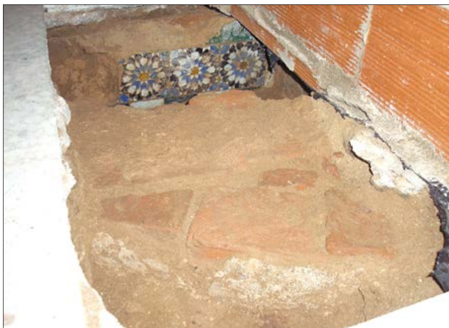
Lám. 3. Fragmento de la solería primitiva aparecida durante las últimas obras realizadas en la parroquia. En la imagen podemos ver la solería de ladrillo y parte del primero de los escalones que daban acceso a la capilla mayor (Fot. cortesía del CEDER La Serena).
