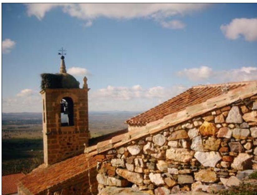
Lám. 2. Vista exterior parcial de la iglesia de Benquerencia de la Serena.
